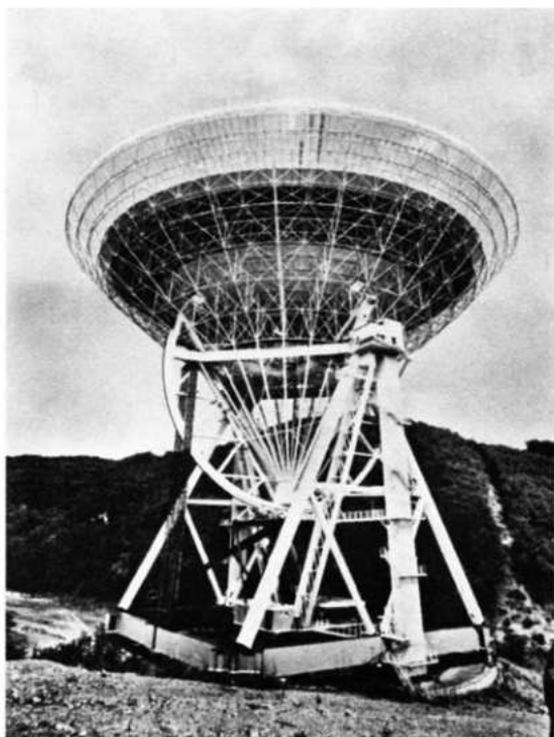
*Il radiotelescoio di Effelberg (Bonn). Paraboloido completamente orientabile da 100 m, completato nel 1971, è il più grande nel mondo nel suo genere, ed è l'unico che superi il MKI di Jodrell Bank.*
