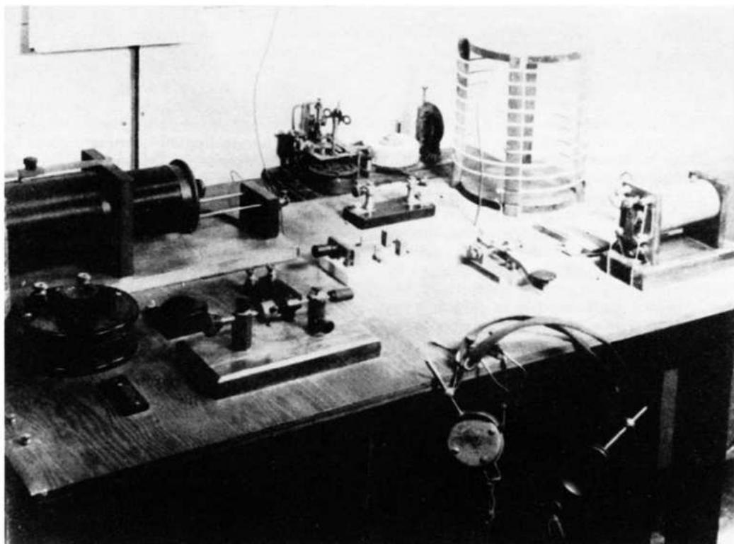
*Una antica stazione a scintilla, con spinterometro fisso e rivelatore al Carburundum. La stazione venne realizzata da uno dei primi amatori, intorno al 1910, quando il governo Statunitense stabilì che gli amatori dovevano discendere sotto i 200 metri di lunghezza d'onda.*
